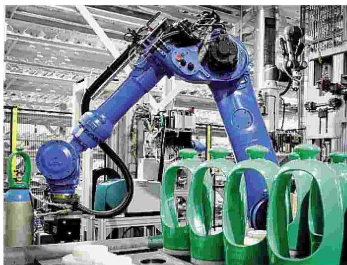
Siad: impianto automatizzato e robotizzato per il riempimento di miscele di gas in bombole ad alta pressione nel nuovo laboratorio
