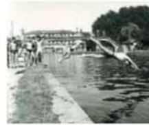
Notturno Le vasche di condensazione della centrale termoelettrica AEM di piazza Trento. Anni Trenta, Archivio storico fotografico AEM
