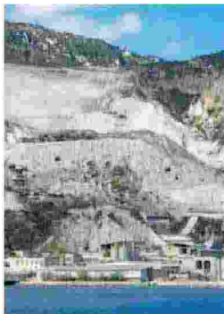
L'impianto dismesso da anni L'ex cava di pomice a Lipari
